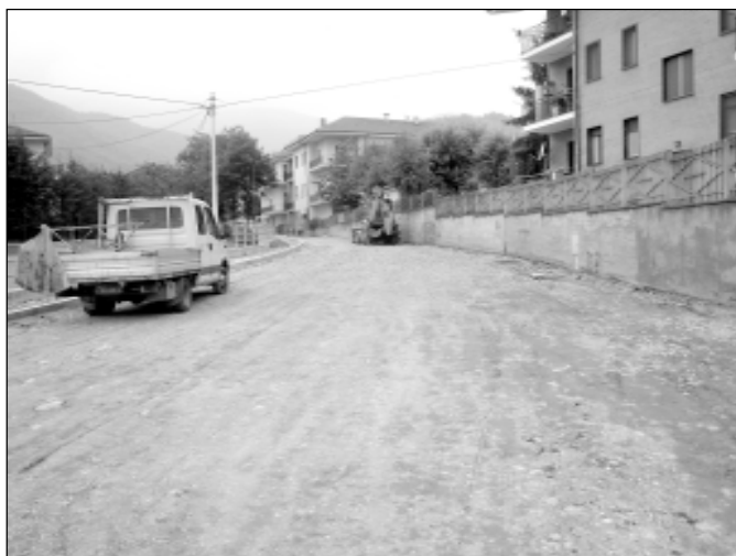
Sono quasi ultimati i lavori in via Vecchia Saluzzo
