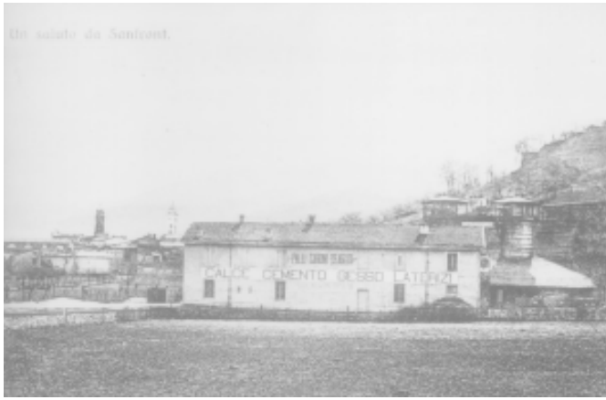
i due forni prima della struttura in cemento armato attorno (battisti)
